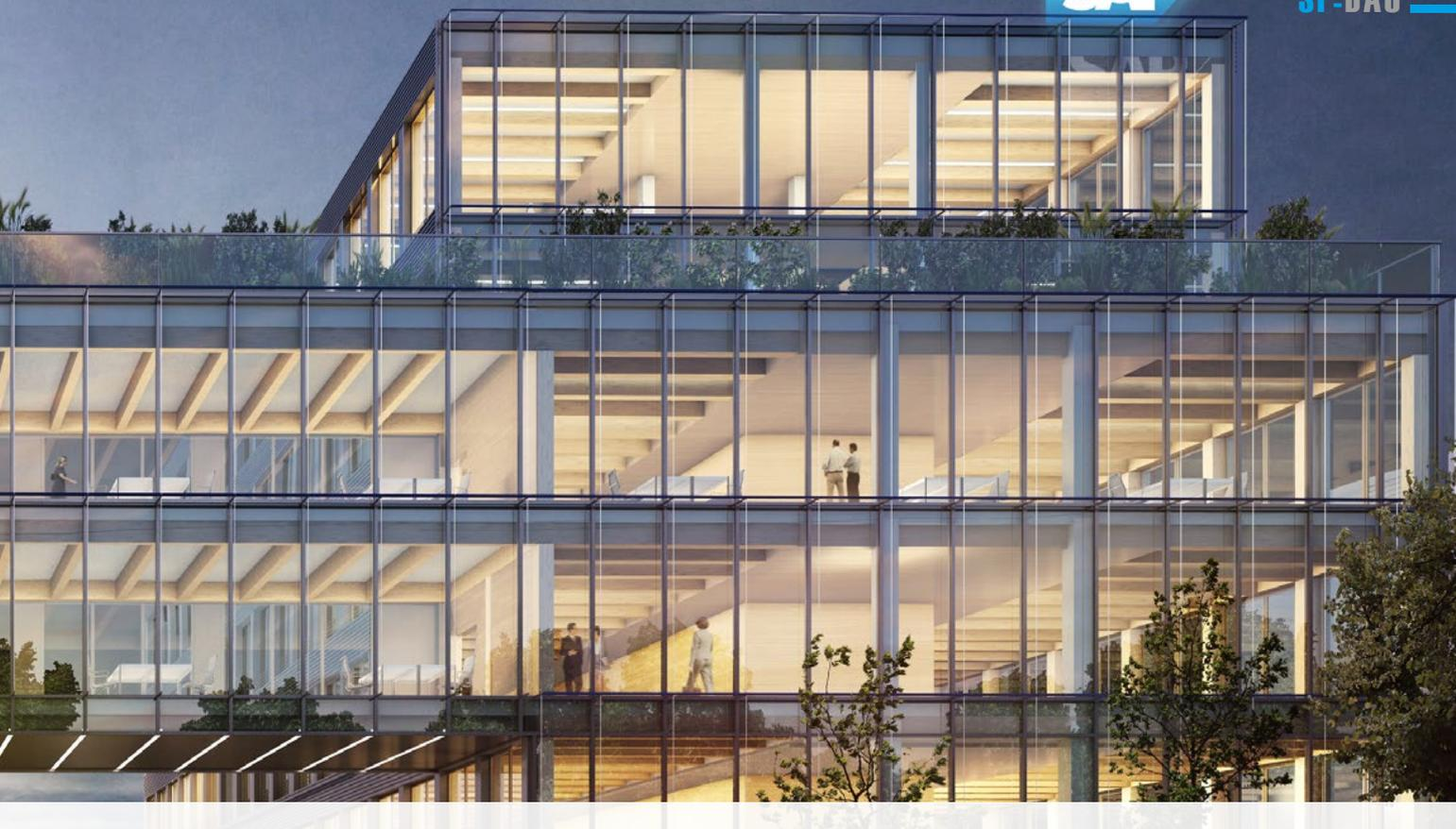
geschoss. Die zweigeschossige Tiefgarage wird 9,50 Meter in den Baugrund eingebunden, bei einem Wasserstand von sechs Metern ab Gründungssohle. Sie reicht über die Grundfläche des Erdgeschosses hinaus, grenzt an die Bestandsgarage an und wird im Außenbereich an das Bestandsgebäude angebunden. Die aufgehenden Geschosse erhalten eine Loch- bzw. Pfosten-Riegelfassade mit Dachgarten sowie Dachbegrünung.
