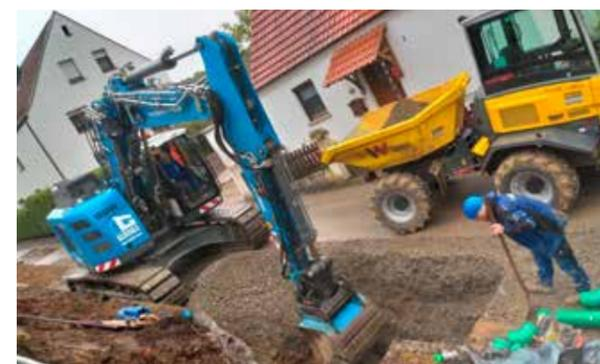
Weitere Tiefbauarbeiten führen wir für den Wasserversorger Rhön-Maintal-Gruppe (RMG) aus, damit ein 150 Meter langer Teilbereich einer Wasserleitung ausgetauscht werden kann. Außerdem werden hier 600 Meter Kabelleerrohre mitverlegt.
