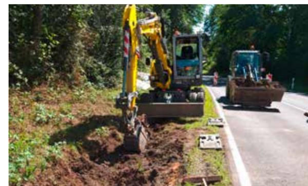
Die Erneuerung der Stromleitungen erfolgt zusammen mit der Firma Bellinger. Die Arbeiten für die benötigten Kabelgräben sehen vor, dass die Gehwege im Ort auf einer Länge von etwa zwei Kilometern aufgedaubt werden. Ins Erdreich verlegt werden schließlich sechs Kilometer lange 20 KV-Kabel und zusätzlich 1,5 Kilometer Kabelleerrohre.
