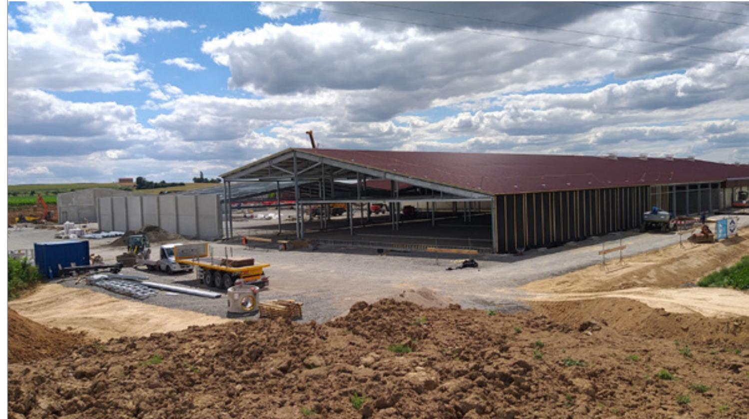
Die Glöckle Montagebau GmbH wurde mit der Herstellung, Lieferung und Montage der Fertigteile für den Bauabschnitt III und IV der Pilzland Vertriebs GmbH im Wernecker Gemeindeteil Eßleben beauftragt. Der Folgeauftrag zu der Erweiterungsmaßnahme umfasst insgesamt 156 Teile für die Brandwände. Die Konstruktion der 140 Meter langen Brandwand des dritten Bauabschnitts ist mit Stahlbetonstützen, Wandplatten und Brandplatten geplant.
