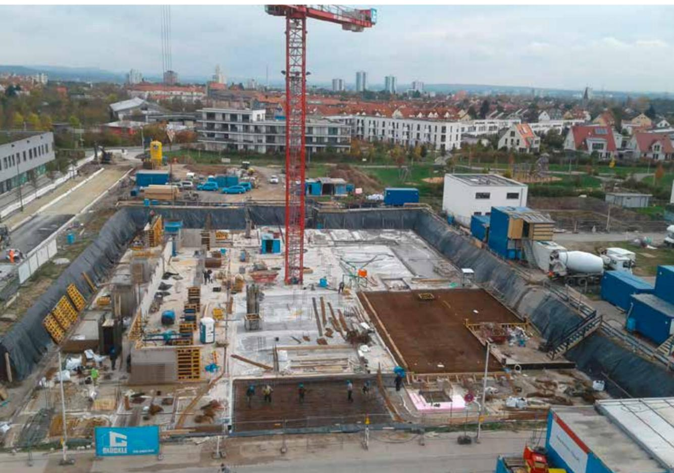
Unter der Trägerschaft der Josephs-Stiftung hat in der Goeschelstraße in Erlangen der Bau eines Wohn- und Geschäftshauses begonnen. Die Aushubarbeiten sind bereits abgeschlossen. Hierbei wurden mehr als 16.000 m<sup>3</sup> Boden bewegt, um für das Untergeschoss aus wasserundurchlässigem Beton Platz zu schaffen. Der Einbau der Bodenplatte wurde im November 2019 fertiggestellt, in den kommenden Wochen wird das Untergeschoss fertiggestellt. Hier wird eine Tiefgarage entstehen.
