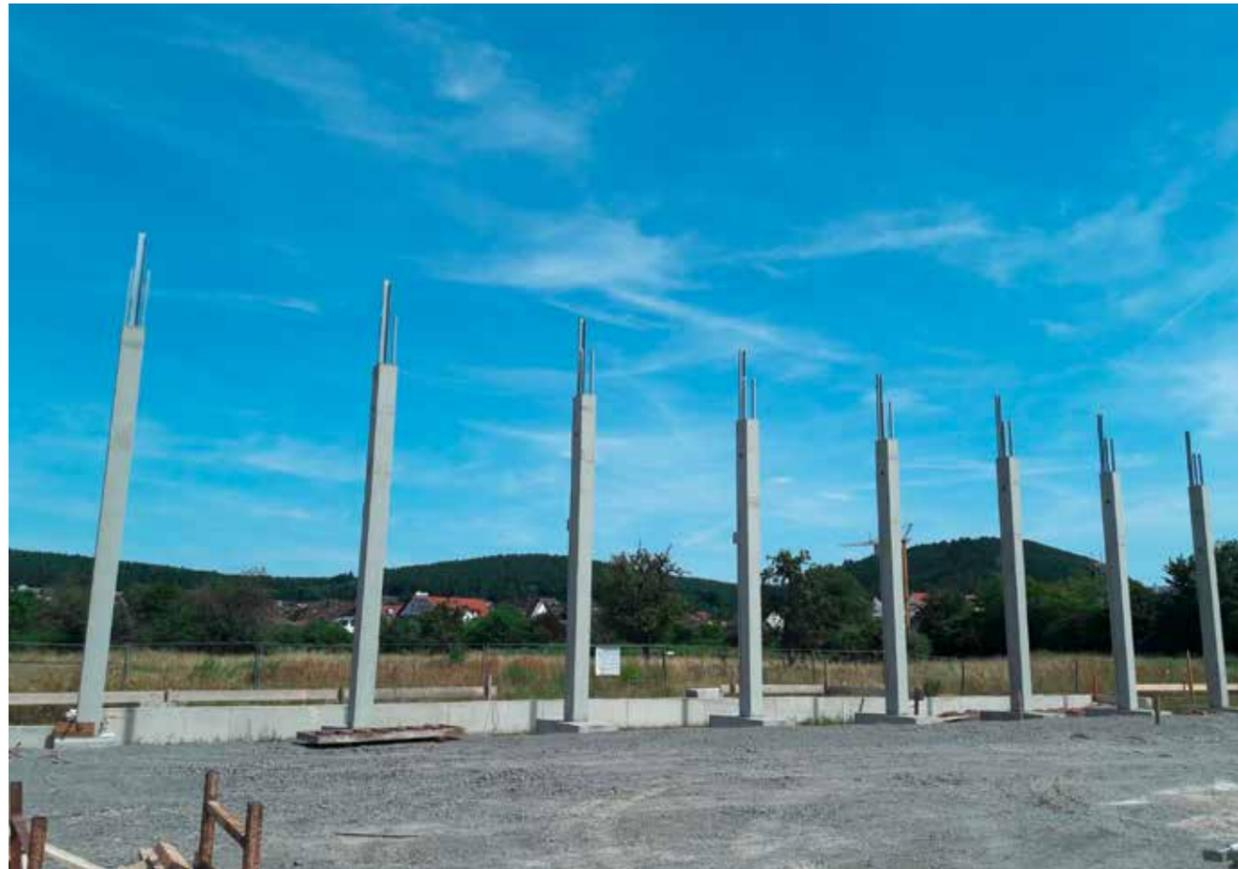
Für den Turnverein Erlenbach e. V. durften wir die Stützen für die optisch ansprechende und 9,5 m hohe Turnhalle aufstellen. Unser Auftraggeber hat anschließend die Außenwände gemauert und mit einer horizontalen Sandwich-Blechfasse verkleiden lassen. Holzbinder kamen beim Dachtragwerk zum Einsatz. Für dieses Projekt haben wir insgesamt 28 Stützen mit einem Volumen von ca. 86 m<sup>3</sup> und etwa 15 t Stahl geliefert und montiert.
