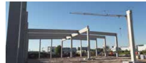
Die zweischiffige Lagerhalle ist ca. 60 m lang, 31 m breit und 9 m hoch. Das Haupttragwerk der Konstruktion besteht aus Stahlbetonstützen mit angeformtem Fundament. Die schlaffbewehrten Stahlbetonbinder liegen an den Außenachsen auf den Stützen und in der Mittelachse auf den Abfangträgern auf. Das Bauvorhaben ist komplett abgeschlossen.
