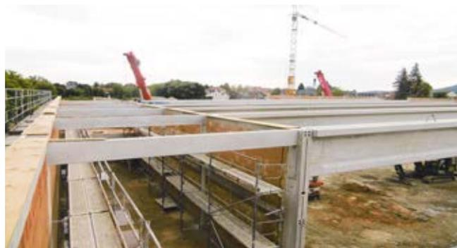
anschließend die Binder mit einem Einzelgewicht von ca. 40 t montieren zu können. Geliefert wurden auch Brandwandüberschlagplatten und zwei Wände zur Auflagerung der Binder. Für die 82 Fertigteile, Stützen mit Fundament, Massivwände, Spannbeton-Parallelbinder, Brandwandüberschlagsplatten, Werbepylon, wurden ca. 315 m<sup>3</sup> Beton, Gewicht ca. 787,5 t, benötigt. Gefertigt wurde in Schwebheim und Meiningen.
