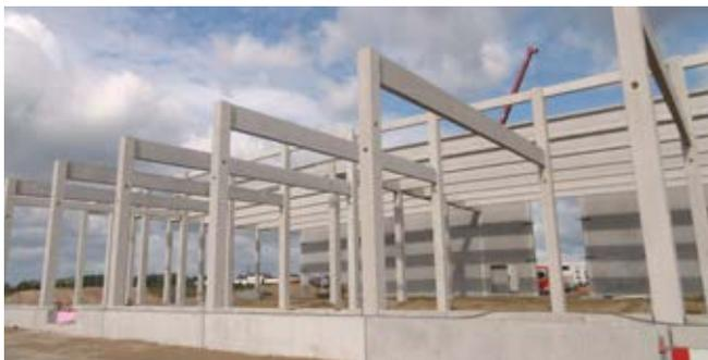
Im Maintal in Schweinfurt wird für den **Lebensmittelgroßhandel Groma** ein Neubau errichtet. Für das eingeschossige Hallengebäude mit den Abmessungen von 77,00 x 57,75 m und einer Gebäudehöhe von 12 m wurde Glöckle mit der Herstellung, Lieferung und Montage der Stahlbetonfertigteile beauftragt. Im Obergeschoss der Halle ist der Technik- und Sozialbereich integriert.
