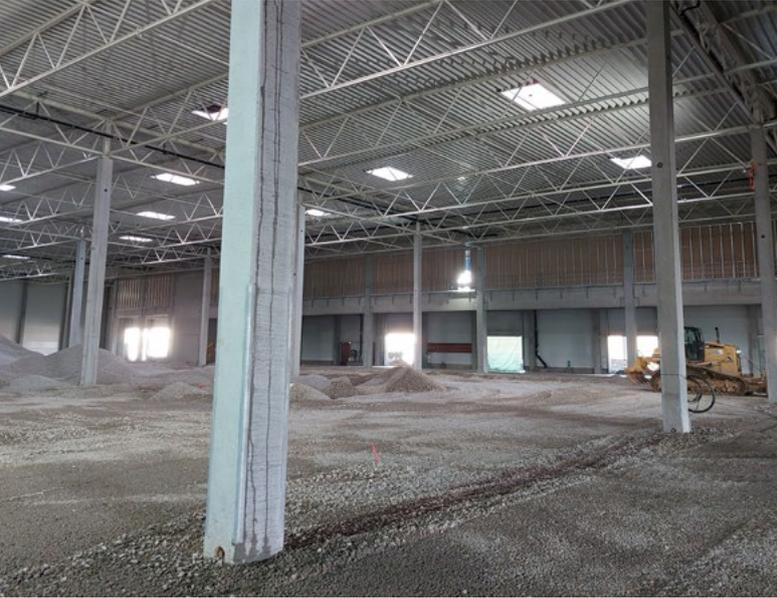
Im Industriepark Kitzingen entsteht derzeit ein neues Logistikgebäude. Für die Planung, Herstellung und Lieferung von Betonfertigteilen wurde erneut unser Montagebau beauftragt. Das Gebäude wird nach Fertigstellung eine Nutzfläche von über 20.000m<sup>2</sup> haben, in zwei Einheiten aufgeteilt und zudem nach dem DGNB-Gold-Standard zertifiziert sein.
